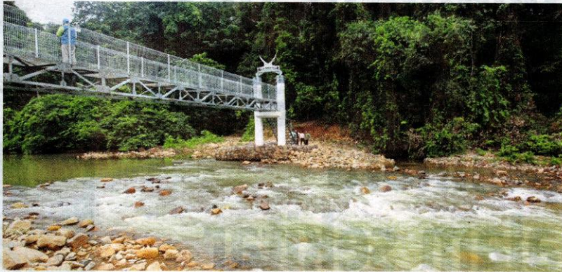
Keadaan sungai Hulu Kuantan turut terjejas akibat aktiviti pembalakan di Hulu Sungai Lembing.
